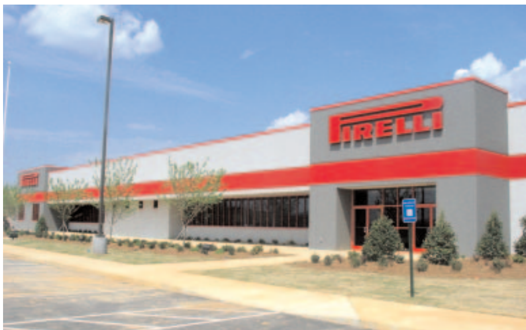
È operativa a Rome, Georgia (Stati Uniti), la prima fabbrica MIRS™ installata oltreoceano.
